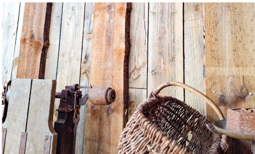
Planche Agricole gris par imprégnation et Planche de plot brute marron par imprégnation. Camping du Vieux Verger Ty Noul (29).
